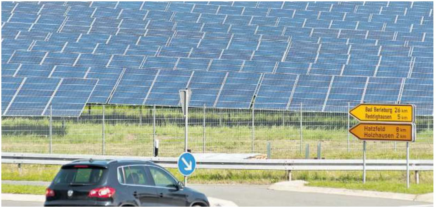
Der neue Solarpark bei Laisa ist fristgerecht einsatzbereit. Ans Netz soll er aber erst im September angeschlossen werden.
